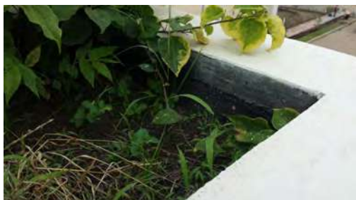
Impermeabilización de jardineras.
