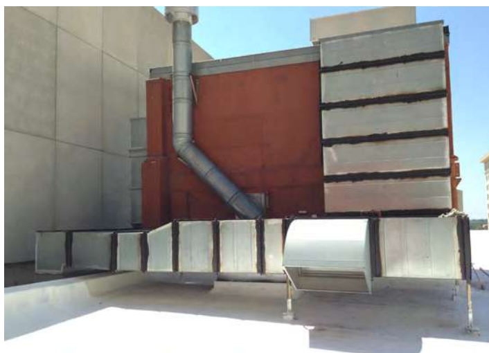
Sellado de ductos de aire.
