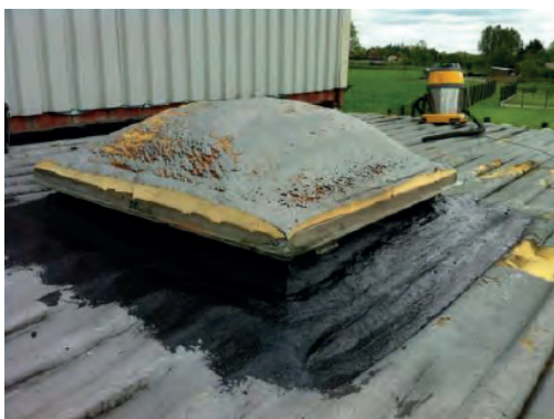
Sellado de transiciones y canaletas.
